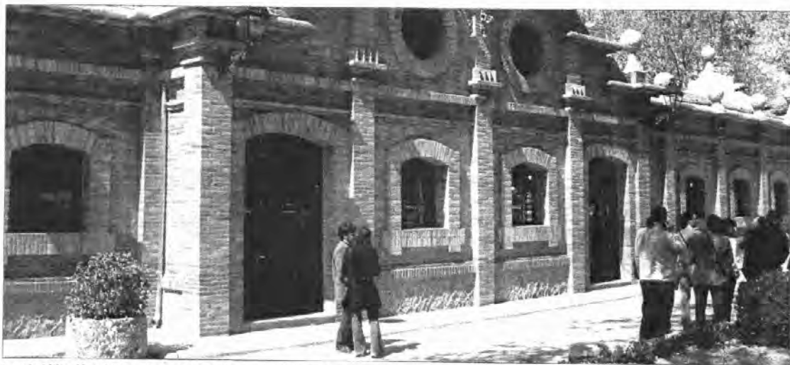
La rehabilitació de la Casa de les Àguiles de Montcada i Reixac ha estat un dels projectes ocupacionals que han estat finançats per l'AMB ■ C.A.
