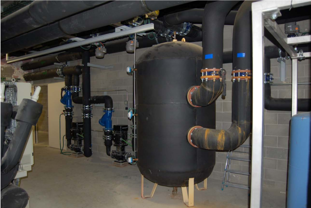
Depòsit estratificat i bombes impulsió col·lectors.
