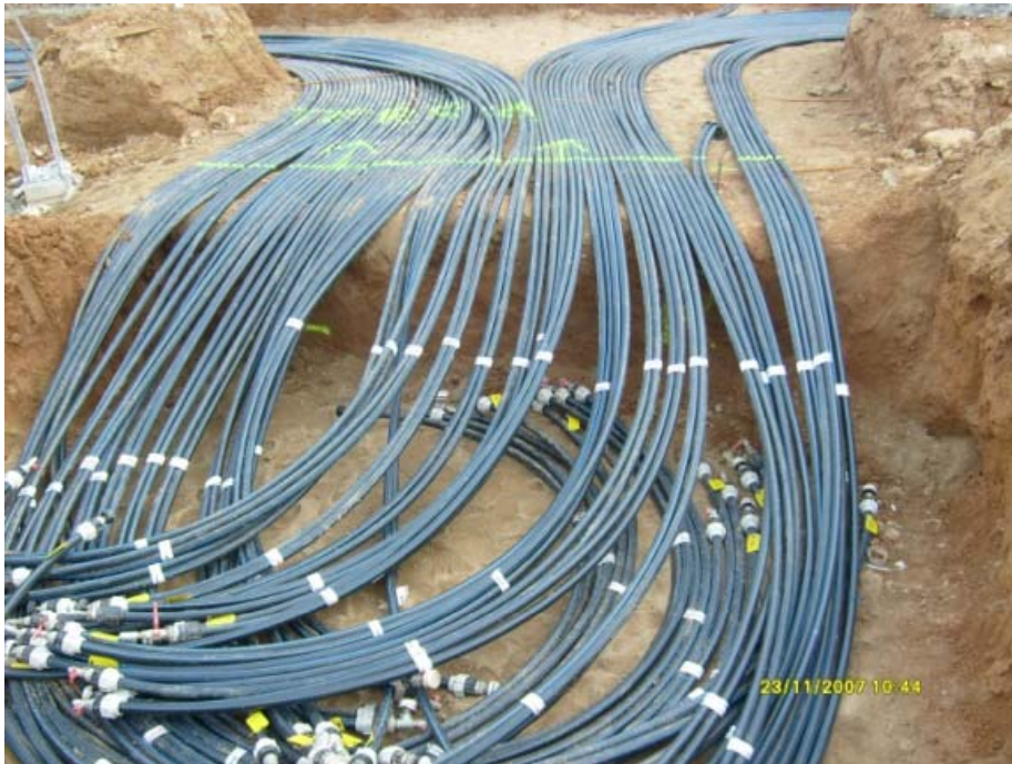
Canalització Sondes
