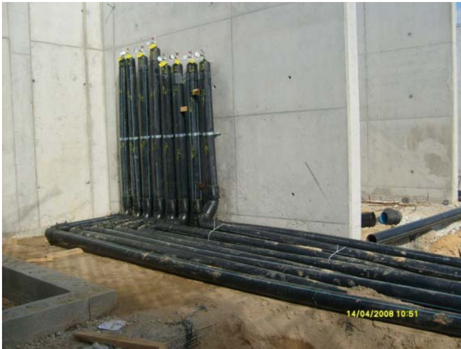
Sala de Col·lectors (fase de construcció)
