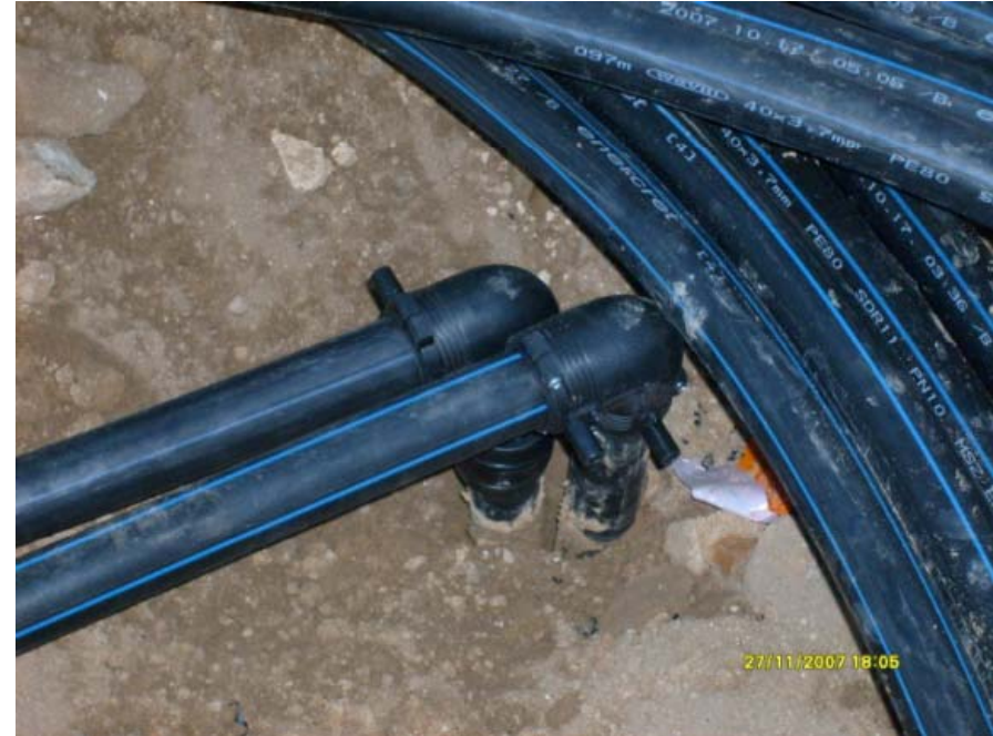
Detall connexió sondes
