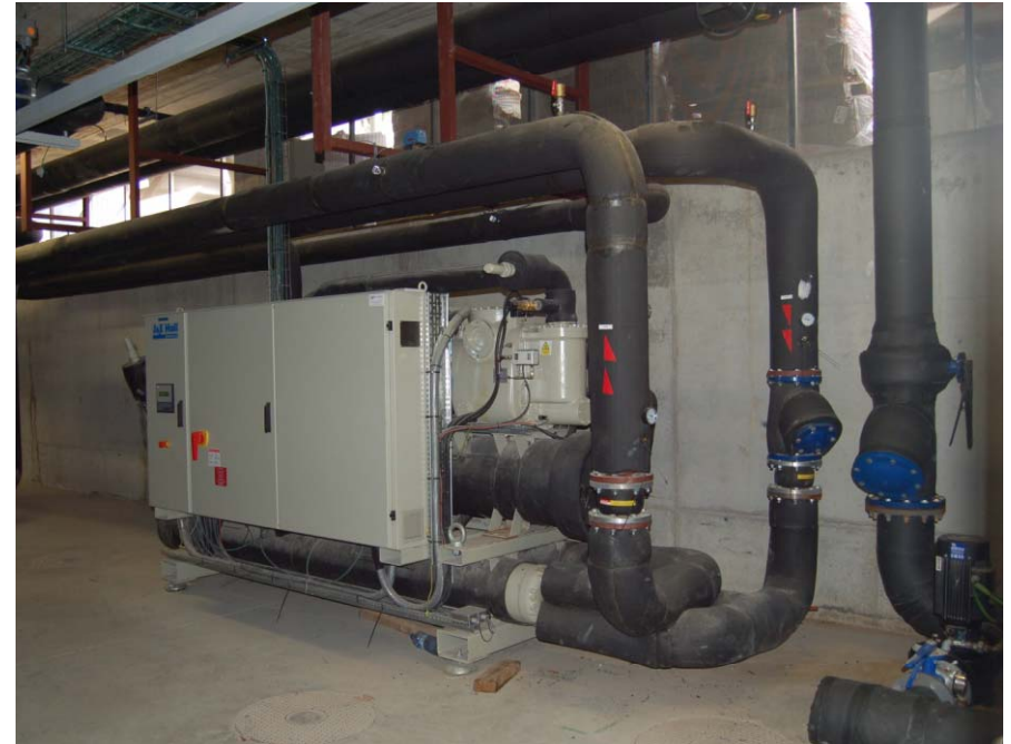
Bomba de calor Geotèrmica
