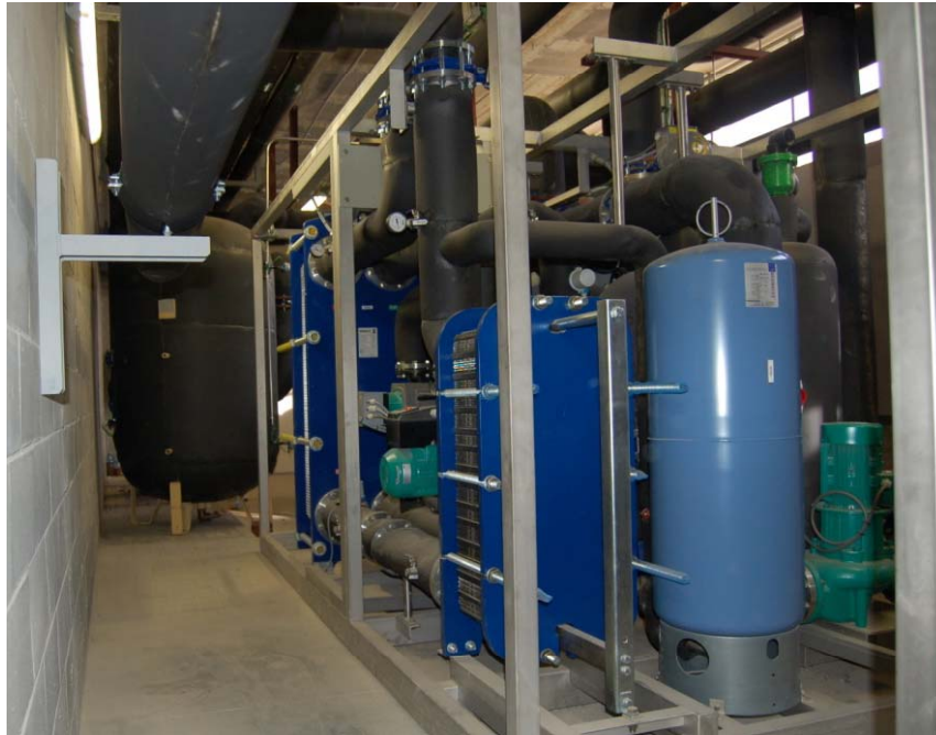
Sala de Geotèrmia (Bescanviadors)
