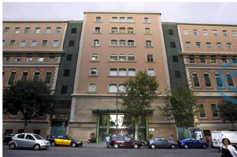
HOSPITAL D'ALTA TECNOLOGIA Hospital Clínic de Barcelona
